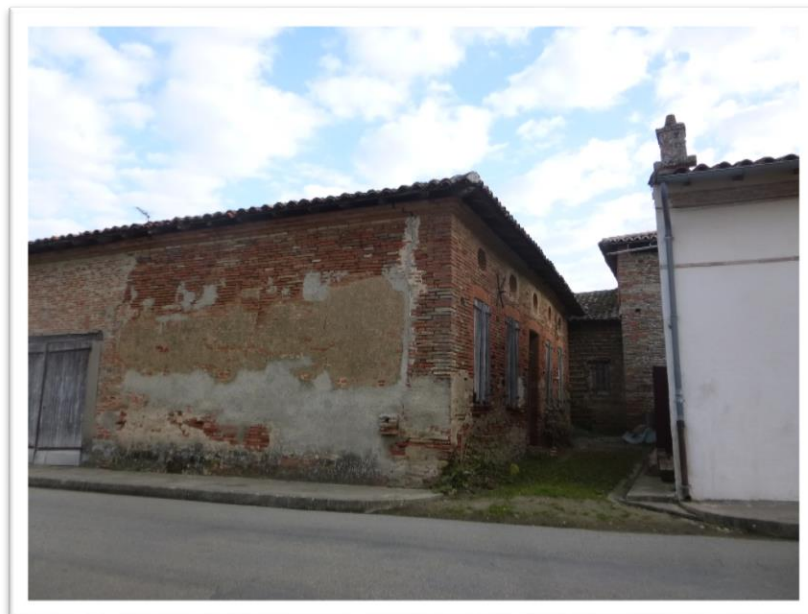
Ancien bâtiment agricole au centre bourg
