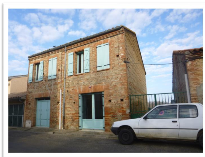
Exemple de réhabilitation
