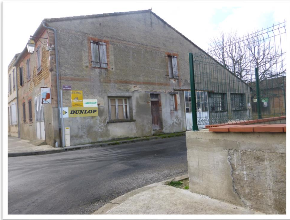
Logement vacant en centre bourg
