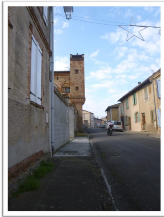
L'ambiance urbaine grâce au bâti
